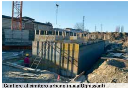
Cantiere al cimitero urbano in via Ognissanti
